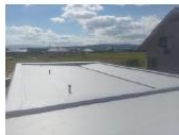
Obr. č. 3: Plochá střecha s PVC fólií
